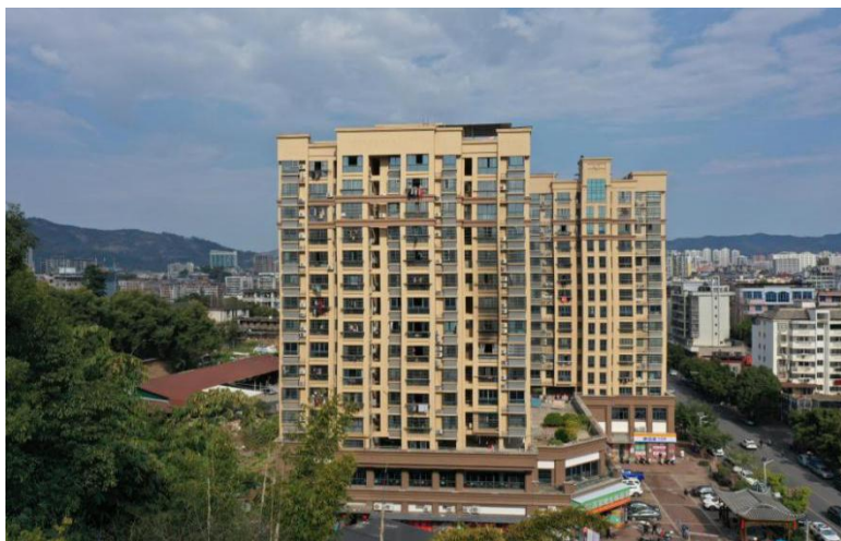
图2：起火建筑外立面
